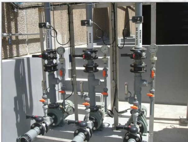
Descarga de camiones cisterna
