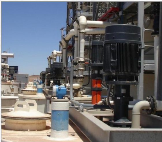
Bomba ETL en tanques cerrados para trasiego de salmueras
